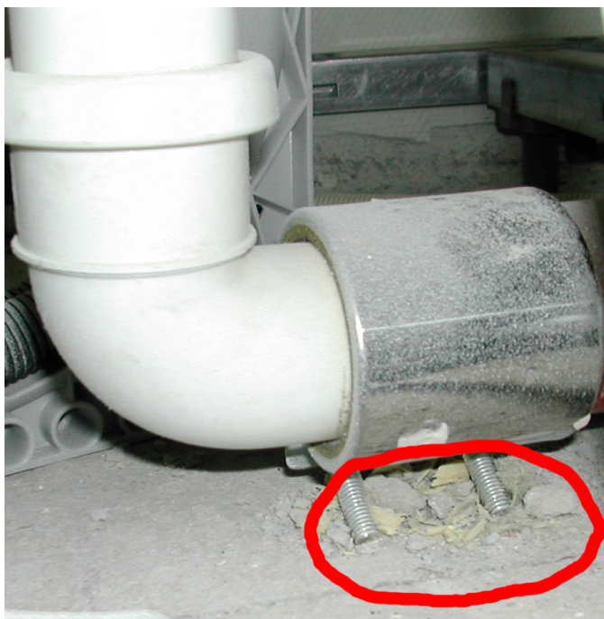
Bild 5: a) Skruva inte fast avloppsröret styvt i en bärande golvregel, b) Undvik styva kontaktpunkter mot stommen, särskilt nära riktningsändringar eller förgreningar. Vibrationerna i röret leds ned via skruvarna till bjälklaget och ger stomljud i detta.
