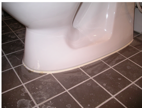
Bilder 12. Montering av WC på golv: a) utan dämpning, skruvad stumt i bjälklaget, b) med stomljudsdämpande list och fog, c) list och fog, d) fogad WC-stol på stomljudslist på plats [Formination: Bild c kommer som originalfil liknande tidigare figurer]
