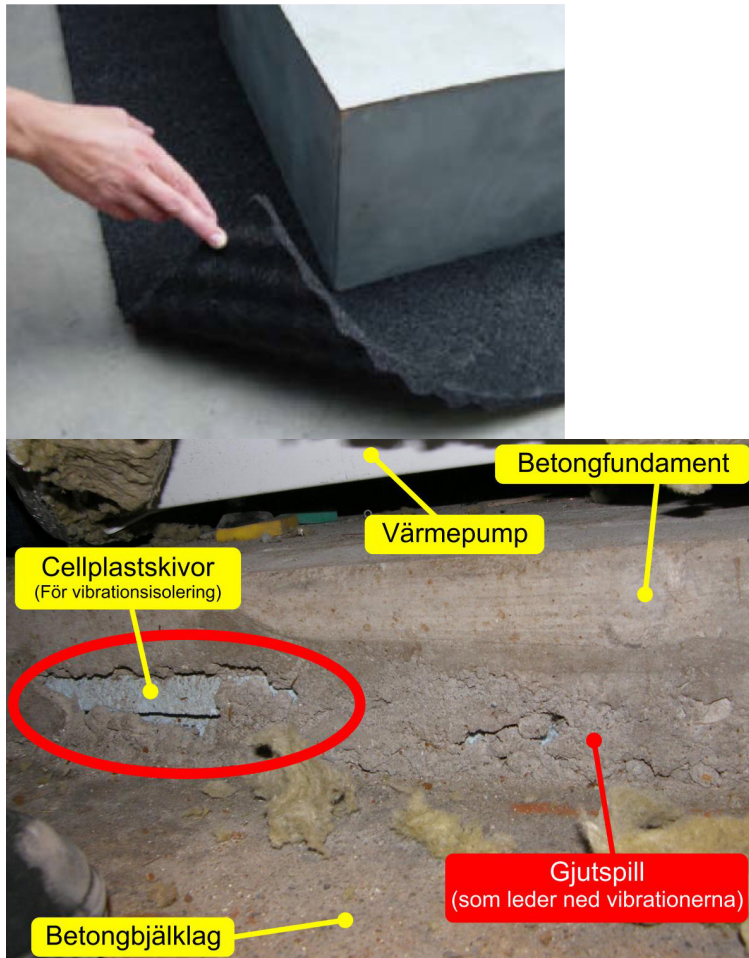
Bilder 9. a) Betong gjuts ovanpå en elastisk matta (bild från Vibratec AB), b) pågjutningen får inte rinna ned mellan skivskarvar eller på utsidan så att spillet låser fast (kortslyter) fundamentet mot bjälklaget. All synligt spill ska tas bort så att fundamentet kan röra sig fritt (mot bjälklaget) innan maskinen monteras. Fundamentet på bilden gav ingen vibrationsdämpning av värmepumpen, men efter rensning fungerade det som avsett.
